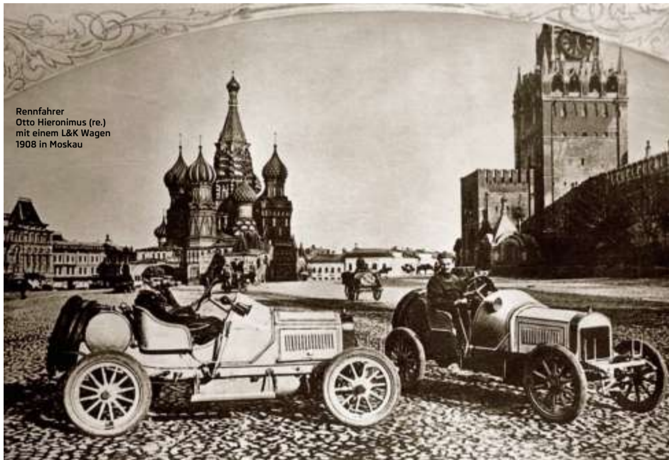
Der legendäre L&K Typ FCR wurde von Hieronimus (am Steuer) konstruiert. Der Wagen besaß einen gewaltigen Hubraum von über fünfeinhalb Litern, und unter seiner ebenso gewaltigen Motorhaube schnaubten 100 PS. Zu Recht bezeichnete man dieses Ungetüm als rollenden Sarg. Der unerschrockene Konstrukteur selbst fuhr schon beim ersten Einsatz des Wagens 1909 auf dem Semmering einen fulminanten Sieg nach Hause.
