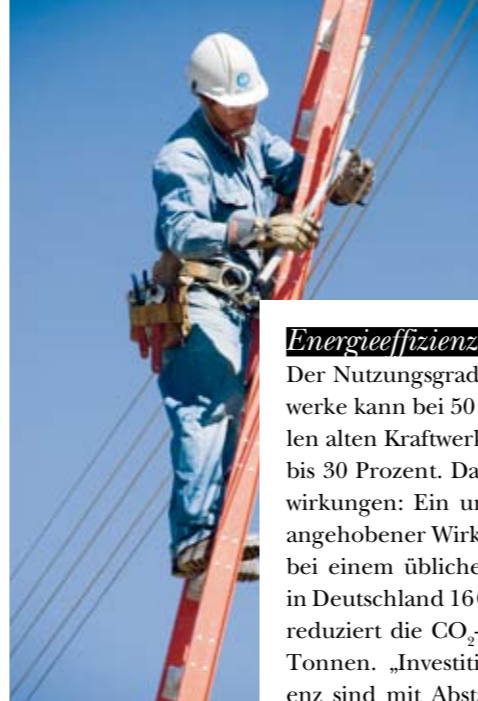
Mehr Effizienz: Instandsetzung einer Stromleitung in Bolivien
